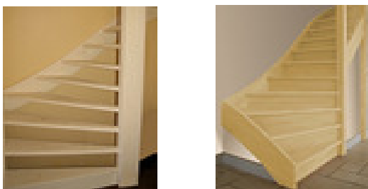
Voorbeelduitwerking van open trap (links) en dichte trap rechts)
